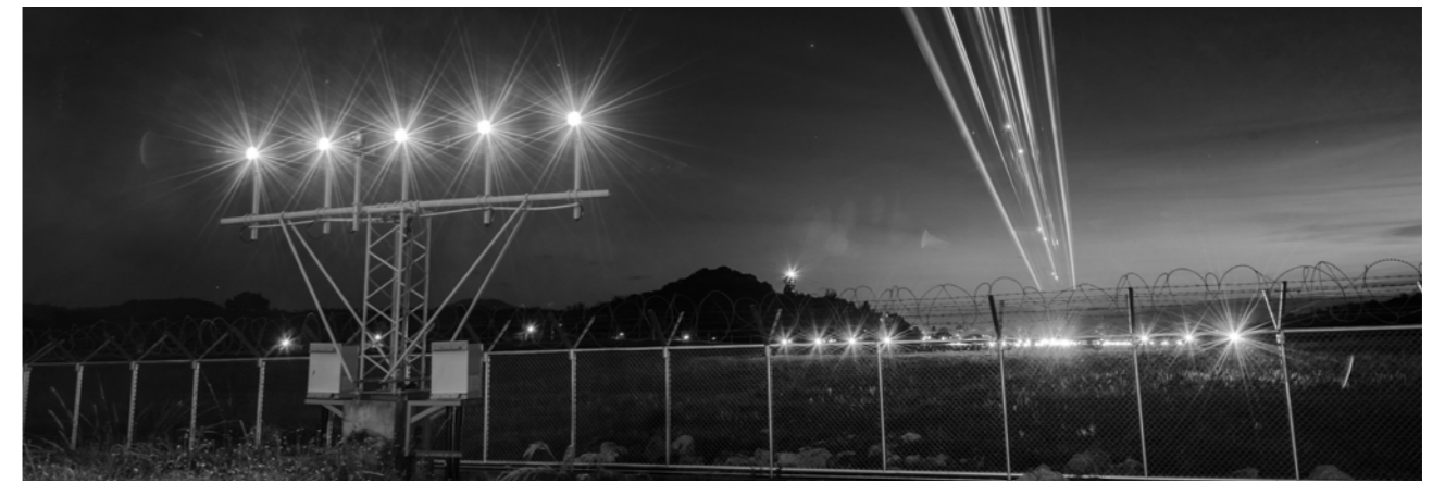
Darauf muss Verlass sein: Sicherheit für die Luftfahrt, hier: Beleuchtung am Airport
