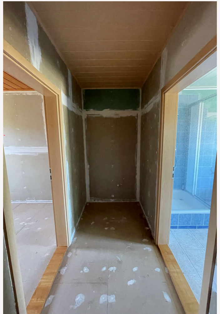
1. Wohneinheit (Ii) im Nebengebäude
