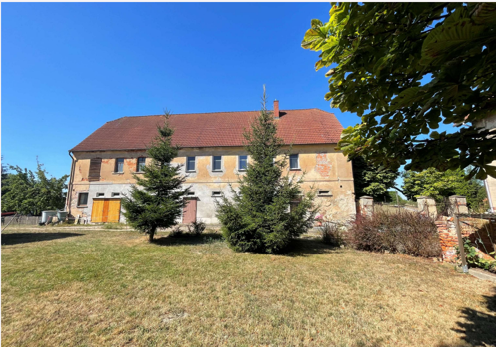
Außenansicht Nebengebäude links
